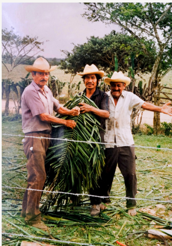
Utrera, Bartolo Málaga y Román Cobos, amarrando colas de palma para cubrir agujero en la culata. Arch. wcr
