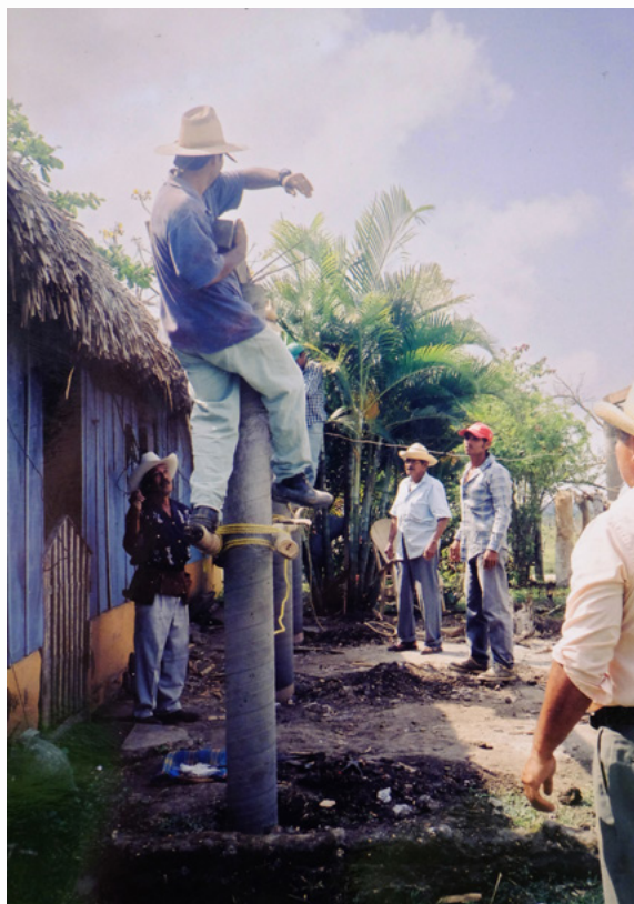
Trazado de la garita junto a la casa. Ya el taller había cambiado a casa de Camerino Utrera. En esta aparecen: don Esteban, de "puntero", dirigiendo a Tacho dónde iría la viga para armar el ajuar. Observan: Luis Oseguera, Ángel Romero "Romerito" y Toño Utrera. Arch. wcr
