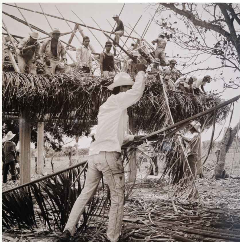
Techa de nuestra casa. Tacho en el caballete, clavando el tercer tapijol del lado izquierdo. Camerino descabezando la palma y Felimón Coli pasa la palma a los techadores. Agustín Estrada.
