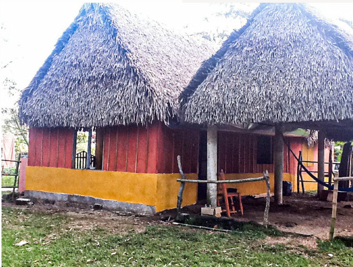
Casa de Tacho y Wendy en El Hato. Arch. WCR
